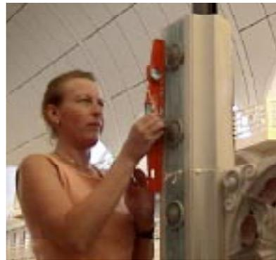
Le collage au plâtre des blocs de grès-cérame est renforcé par des cavaliers métalliques réunissant deux par deux les blocs du devant et ceux de derrière (voir flèche ci-dessus à droite). Ce procédé appartenant à la conception d'origine a été utilisé tout au long du montage. Il s'agit d'un acier gainé de plastique contre l'oxydation.
