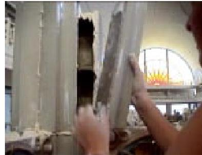
C'est à cette étape que les deux blocs sont ajustés l'un à l'autre et que les joints de gauche et de droite sont écrasés pour obtenir la meilleure verticalité possible des deux blocs. C'est en effet le joint central qui sera le plus visible sur la face intérieure de l'Arche.
