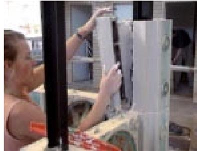
Les joints horizontal et vertical sont préparés par l'apport de plâtre frais et le bloc de gauche est mis en place sans que le joint vertical de gauche soit trop écrasé...
