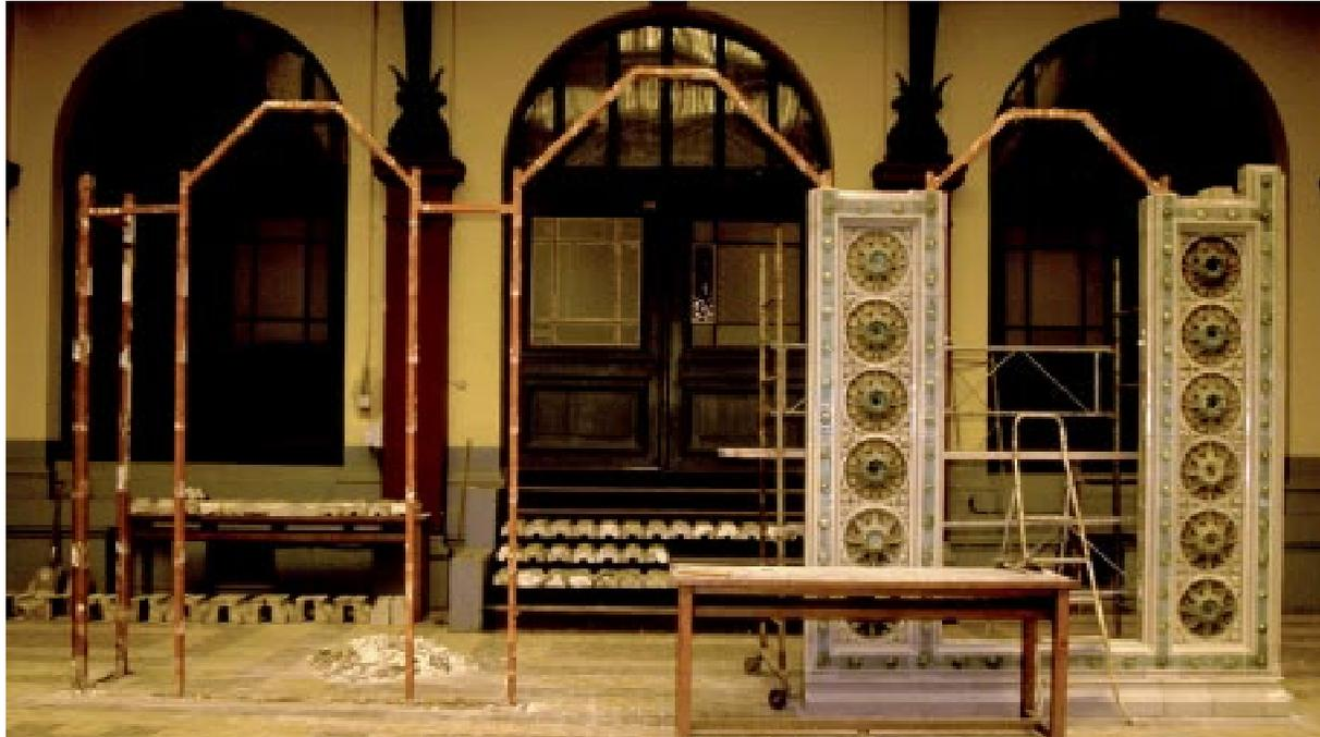
D'autres fissures et cassures pouvaient être repérées avant démontage dont nous découvrirons ensuite qu'elles n'ont pas été l'objet de restauration ancienne ; celles-ci étaient en effet dues à l'oxydation des liens de fer noyés dans le plâtre du montage, le hall l'Ensaït étant en effet sujet alors à des défauts d'étanchéité de la toiture. Certaines de ces fissures céderont d'ailleurs lors du démontage.
