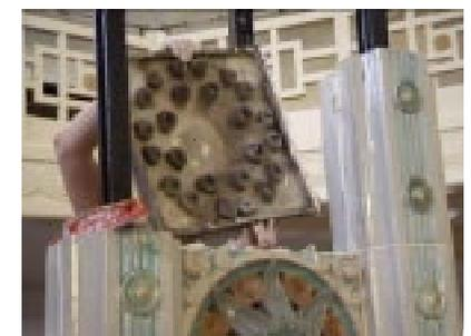
Pour installer la seconde rosace au dos de la première, il est préférable d'attendre que le plâtre de scellement de la première ait effectué sa prise. L'excédant du plâtre pris est donc ôté avant sa prise puis remplacé par du plâtre frais pour ce qui est du joint horizontal. Le plâtre du joint vertical de gauche, mais aussi un joint à droite et en haut destiné à coller les rosaces entre elles, est alors déposé sur la tranche de la seconde rosace avant que celle-ci soit mise en place.
