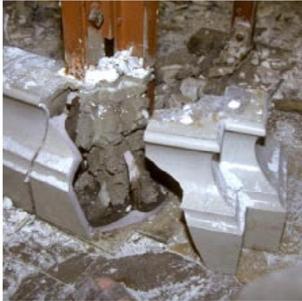
Ci-dessus, éclatement d'une pièce de la base montée au ciment coulé directement dans la céramique autour de l'armature
