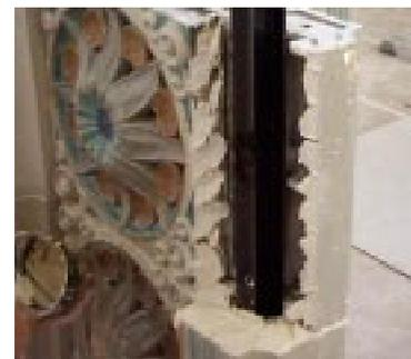
pour chaque rosace sont à ce stade installés dans le joint de plâtre frais ; c'est à dire deux carrés sur le joint vertical pour retenir les rosaces solidaires des blocs de l'extrémité, et deux carrés sur le joint horizontal pour renforcer la solidarité entre rosaces de rangs successifs.
