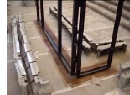
La structure en acier est fixée au sol par six fers verticaux enfoncés dans un fourreau métallique lui-même scellé dans la dalle de béton à une vingtaine de centimètre de profondeur. L'ensemble est démontable.
