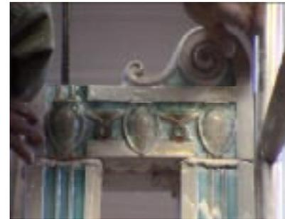
Dès lors que tous les blocs sont en place demeure une multitude de détails à améliorer : débordement ou lacunes sur des «kilomètres» de joints de plâtre, comme la correction en trompe l'oeil destinée à atténuer l'irrégularité d'épaisseur des mêmes joints de
