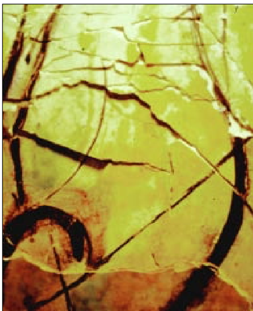
Fig.1 - "une explosion au ralenti". Poussés par le mur, les carreaux éclataient en de multiples fragments. Fig.2 - Coups de soleil et ruissellements de condensation détruisent la glaçure d'un décor de Deck.
