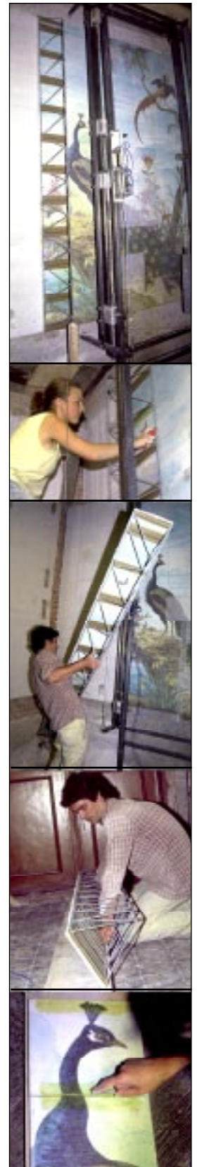
Fig.7 - Dépose par rangées solidaires de la céramique murale «les glycines» de Theodore Deck
