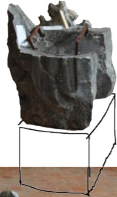
Les deux blocs de l'assise de la flèche, ici posés sur le même niveau que les blocs du premier rang, devaient être réhaussés par un volume d'environ 30 cm de hauteur disparu avec le plateau tournant.
