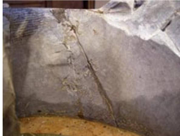
A gauche, des résidus de mortier de collage sur la zone lisse à la jonction de deux blocs.
